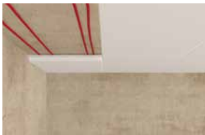
Panneaux d'isolation au plafond
