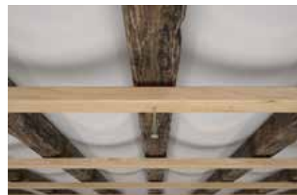
Structures faux plafonds
