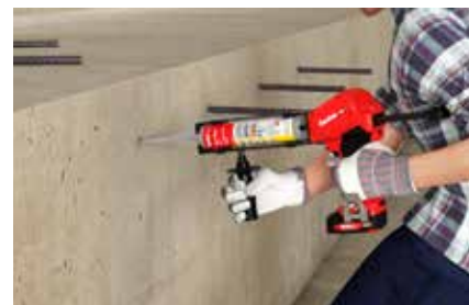
Reprise de fers à béton
