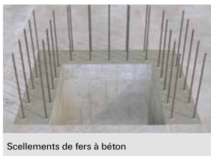
Scellements de fers à béton
