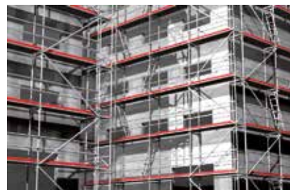
Echafaudages de façade
