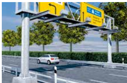
Portiques de signalisation
