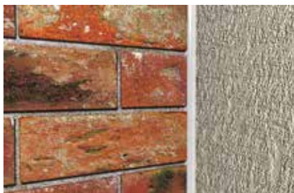
Joint de construction entre voiles
