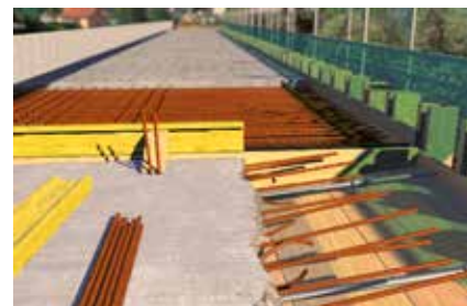
Fixation de fers à béton
