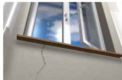
Fermeture de fissures de mur à l'intérieur
