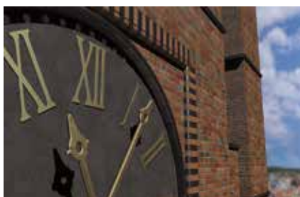
Réparation de mur de parement
