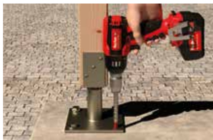
Pied de poteau
