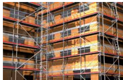
Echafaudages de façade
