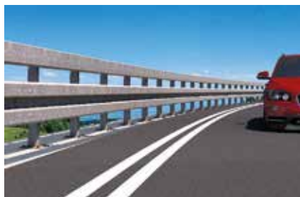
Glissières de sécurité
