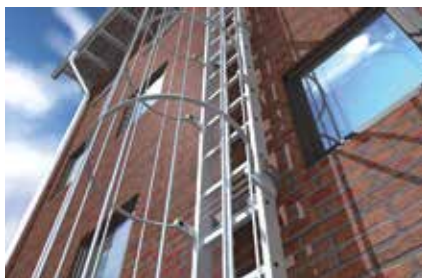
Echelles de secours
