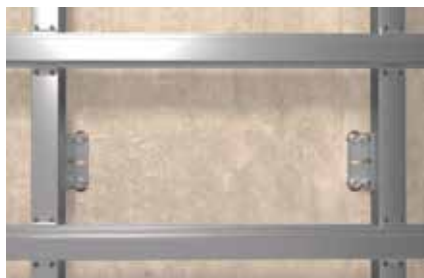
Ossatures de façade métalliques
