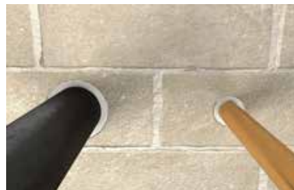
Calfeutrement de tuyauteries métalliques
