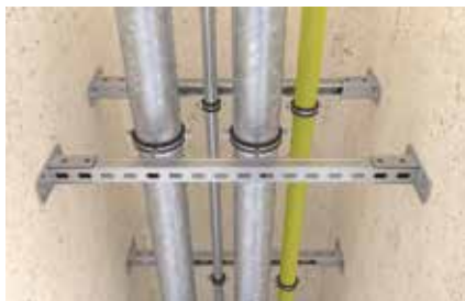
Fixation de tuyaux d'évacuation
