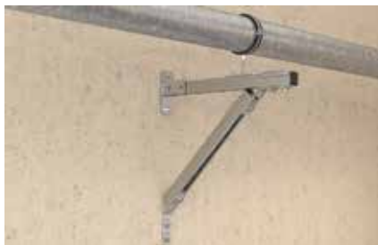
Tube acier sur console renforcée
