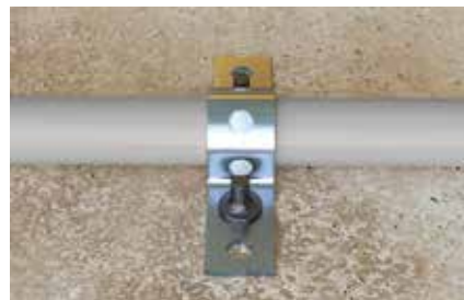
Fixation de bandes perforées
