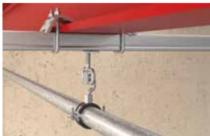
Rail sur poutrelle métallique
