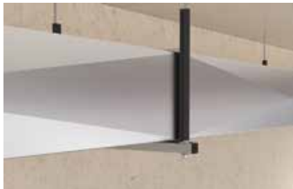
Fixation du conduit d'air avec rails
