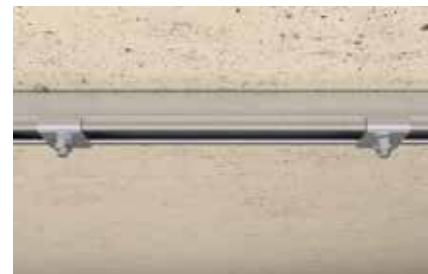
Installation de rails au mur
