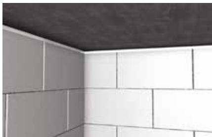
Joint de construction entre voiles
