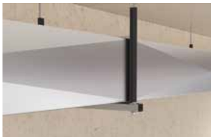
Fixation du conduit d'air avec rails
