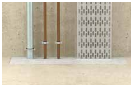
Pénétrations multiples à travers dalles
