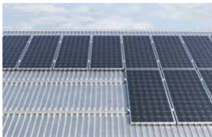
Couverture en tôle d'acier nervurée
