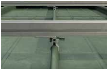
Toiture à joint debout
