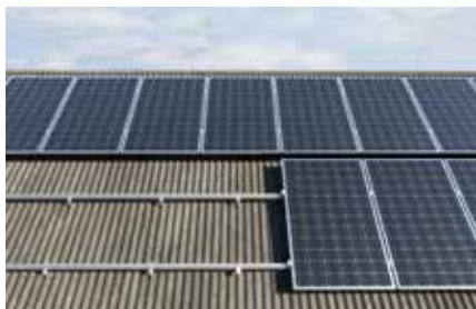
Toiture inclinée avec couverture en tôle ondulée
