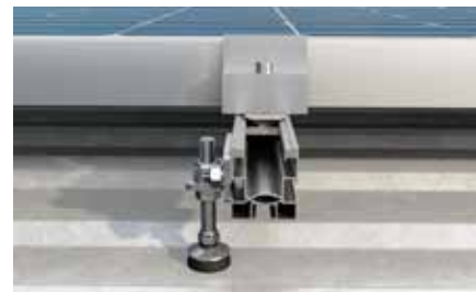
Toiture inclinée avec couverture en tôle trapézoïdale
