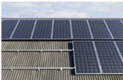
Toiture inclinée avec couverture en tôle ondulée
