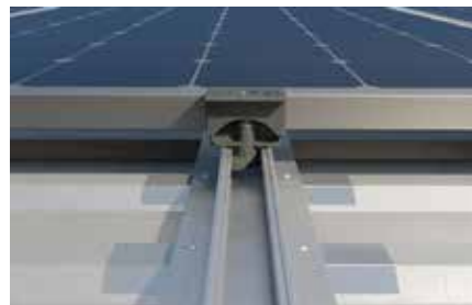
Toiture inclinée avec couverture en tôles d'acier nervurée
