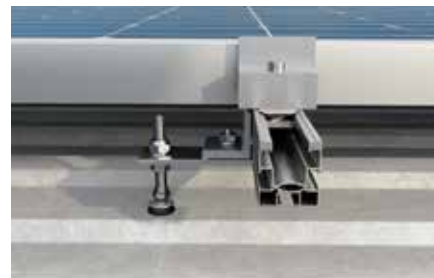
Toiture inclinée avec couverture en tôle trapézoïdale
