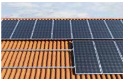
Toiture inclinée avec couverture en tuile canal
