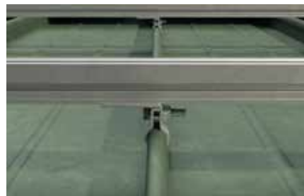
Toiture inclinée avec couverture à joint debout arrondi
