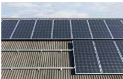
Toiture inclinée avec couverture en tôle ondulée
