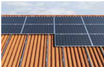
Toiture inclinée avec couverture tuile et panneaux photovoltaïques en orientation paysage
