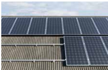
Toiture inclinée avec couverture en tôle ondulée
