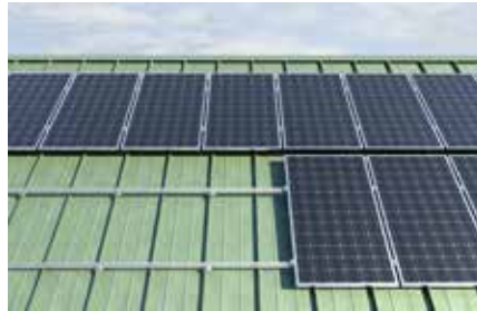
Toiture inclinée avec couverture en joint debout
