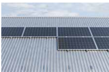
Couverture en tôle d'acier nervurée
