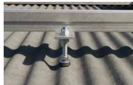
Toiture inclinée avec couverture en tôle ondulée
